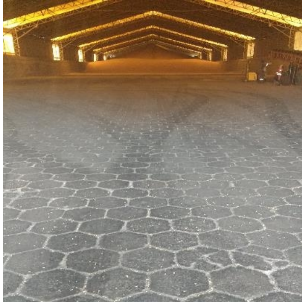
Figura 3 –Lajota sextavada de concreto nos Armazéns
