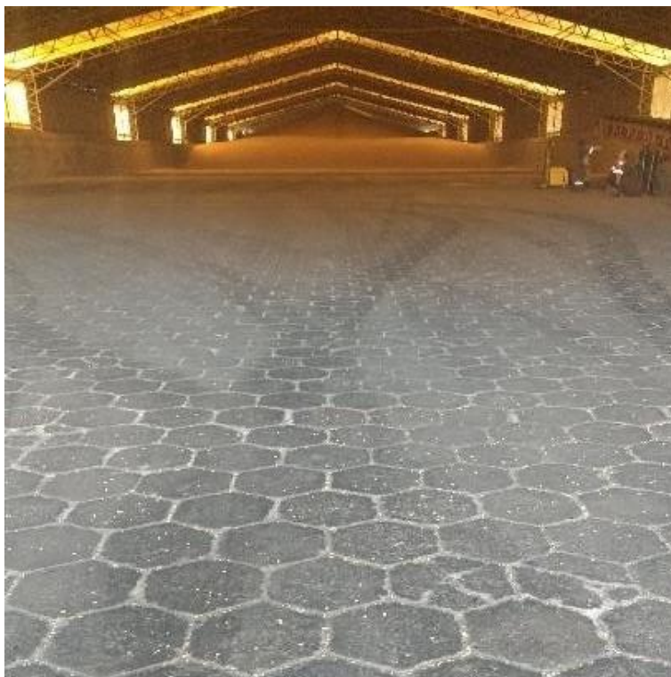
Figura 2 –Lajota sextavada de concreto nos Armazéns
