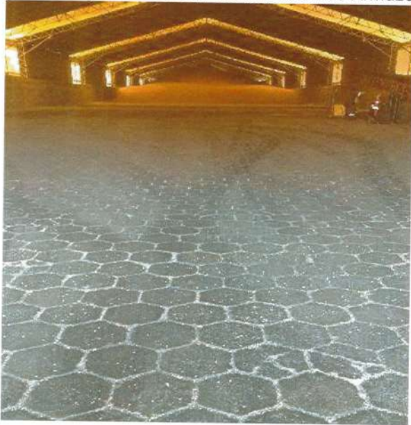
Figura 3 –Lajota sextavada de concreto nos Armazéns
