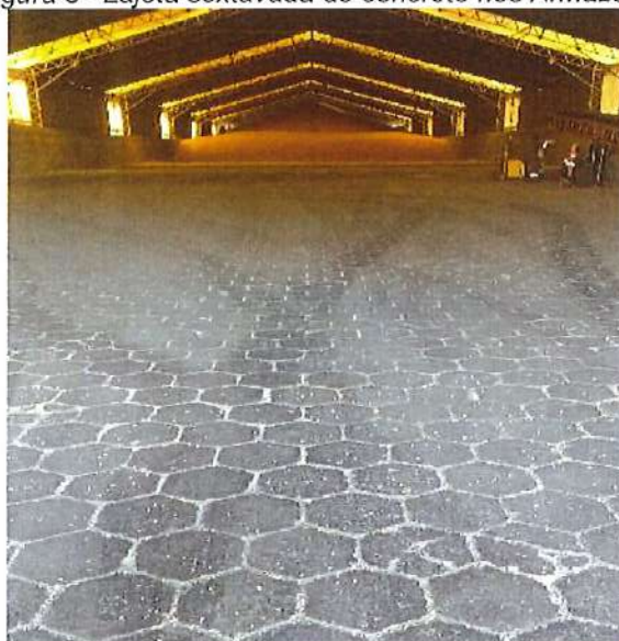
Figura 3 –Lajota sextavada de concreto nos Armazéns
