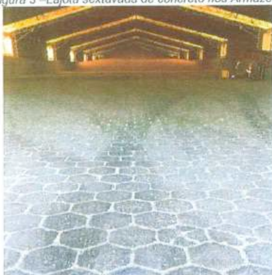
Figura 3 –Lajota sextavada de concreto nos Armazéns
