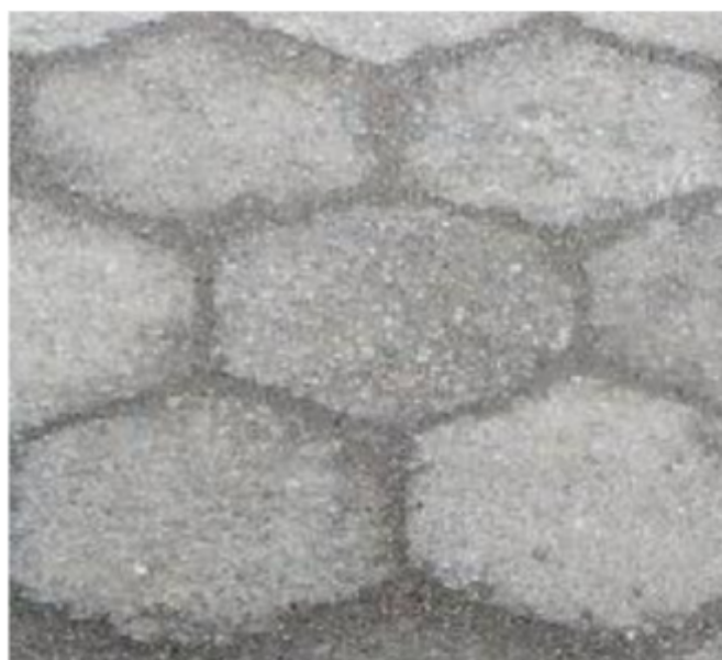
Figura 3 –Lajota sextavada de concreto em detalhe
